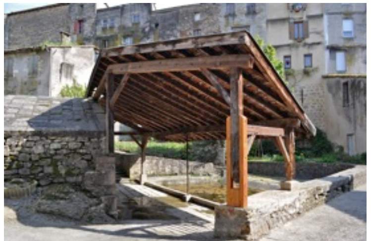
Lavoir de la Marmory
