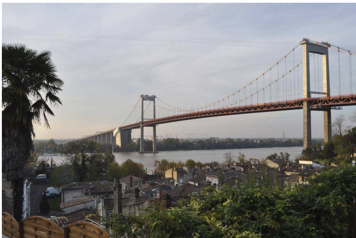
Vue du pont d'Aquitaine depuis le Vieux Lormont
