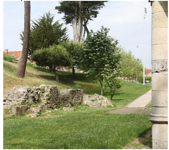
Partie droite du transept (écroulée et non rebâtie)
